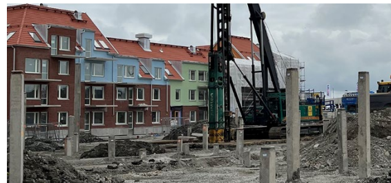
Pålning på Kv. Hercules juni 2023 med kv. Spitfire i bakgrunden
