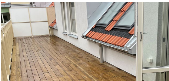
En av takterrasserna på Kv. Spitfire
