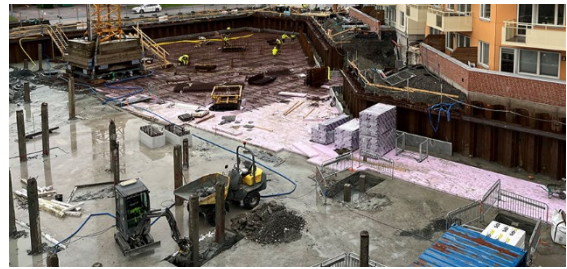
Kv. Hercules med del av kv. India i bakgrunden
