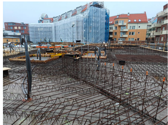
Utsikt över det norra huset (Kv. Hercules) från det södra husets grund, från början av december 2024
