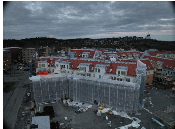
En tidig morgonbild på det norra huset där man kan skymta fasaden på det översta planet, från början av december 2024
