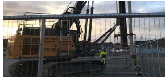
Första pålen i marken Kv. Radarflyget 2 december 2018.
