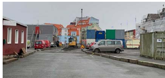
Arbete med genomfartsväg december 2019.
