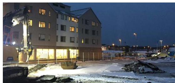
Start av byggnation Kv. Spitfire februari 2022.
