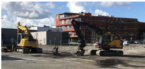
Kv. India redo inför byggnationsstart september 2019.
