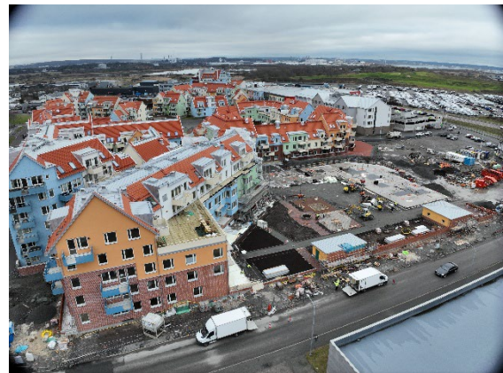
Kv. Hercules norra hus i slutet av januari, i bilden ser vi en stor vacker takterrass i sydvästligt läge
