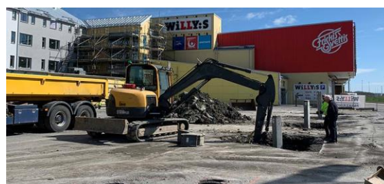
Kv. Radarflyget 2 parkeringshus pålning maj 2020
