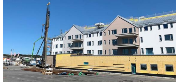
Kv. Radarflyget 2 pålning april 2020.
