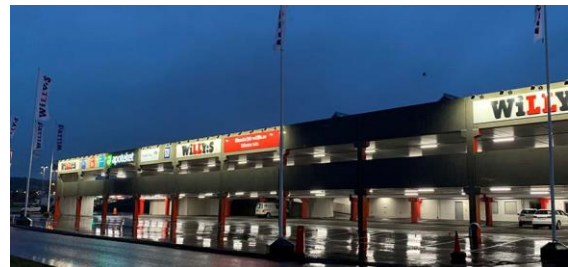
Kv. Radarflyget 2 januari 2021 – parkeringshuset.
