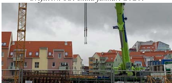
Arbeten Kv. India januari 2020.
