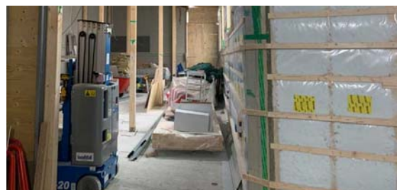
Pågående arbeten Torslanda Hotel januari 2020.
