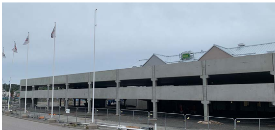
Kv. Radarflyget 2 parkeringshus september 2020.
